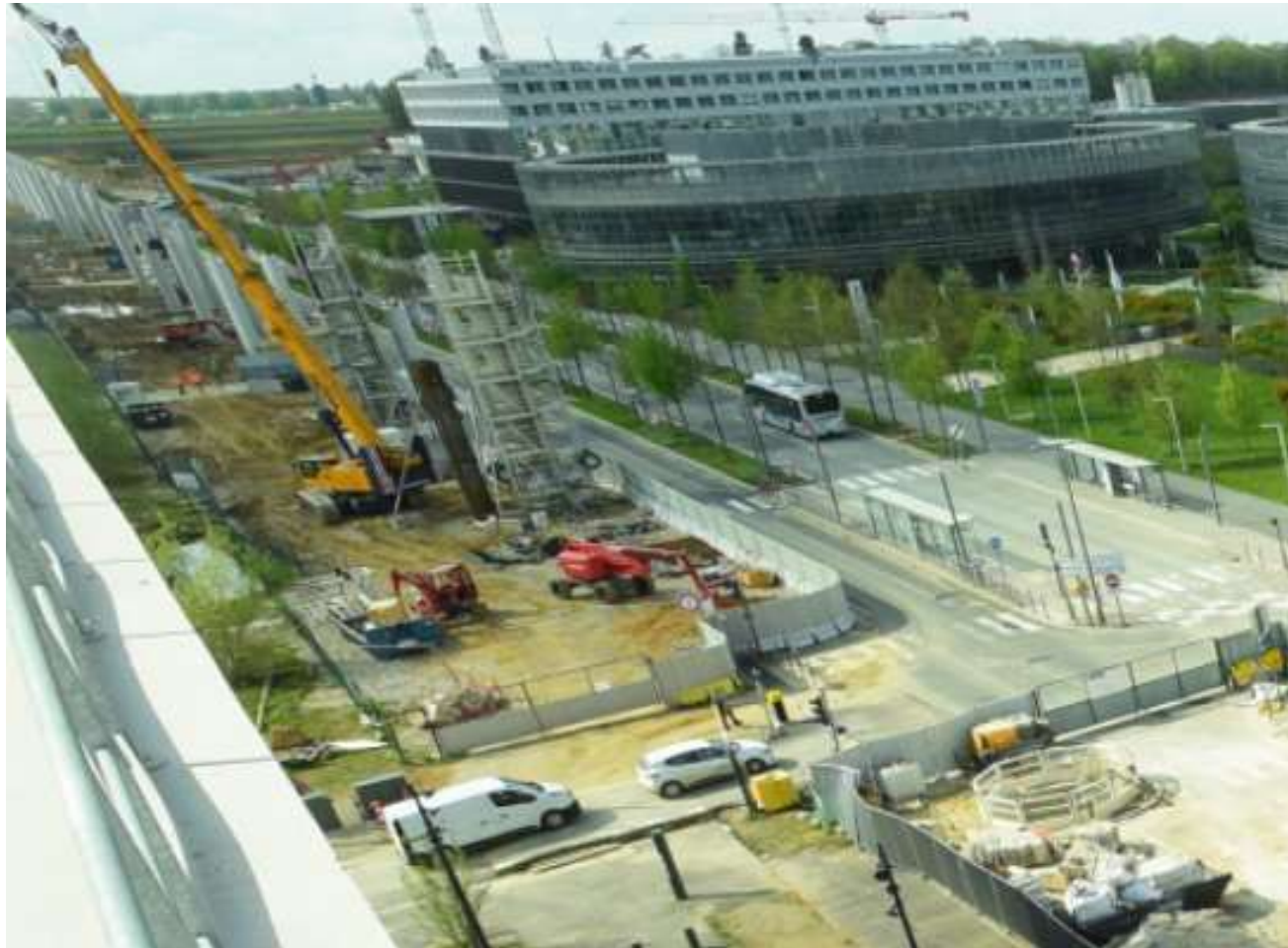
Piles en cours de réalisation sur le Bd Monge
