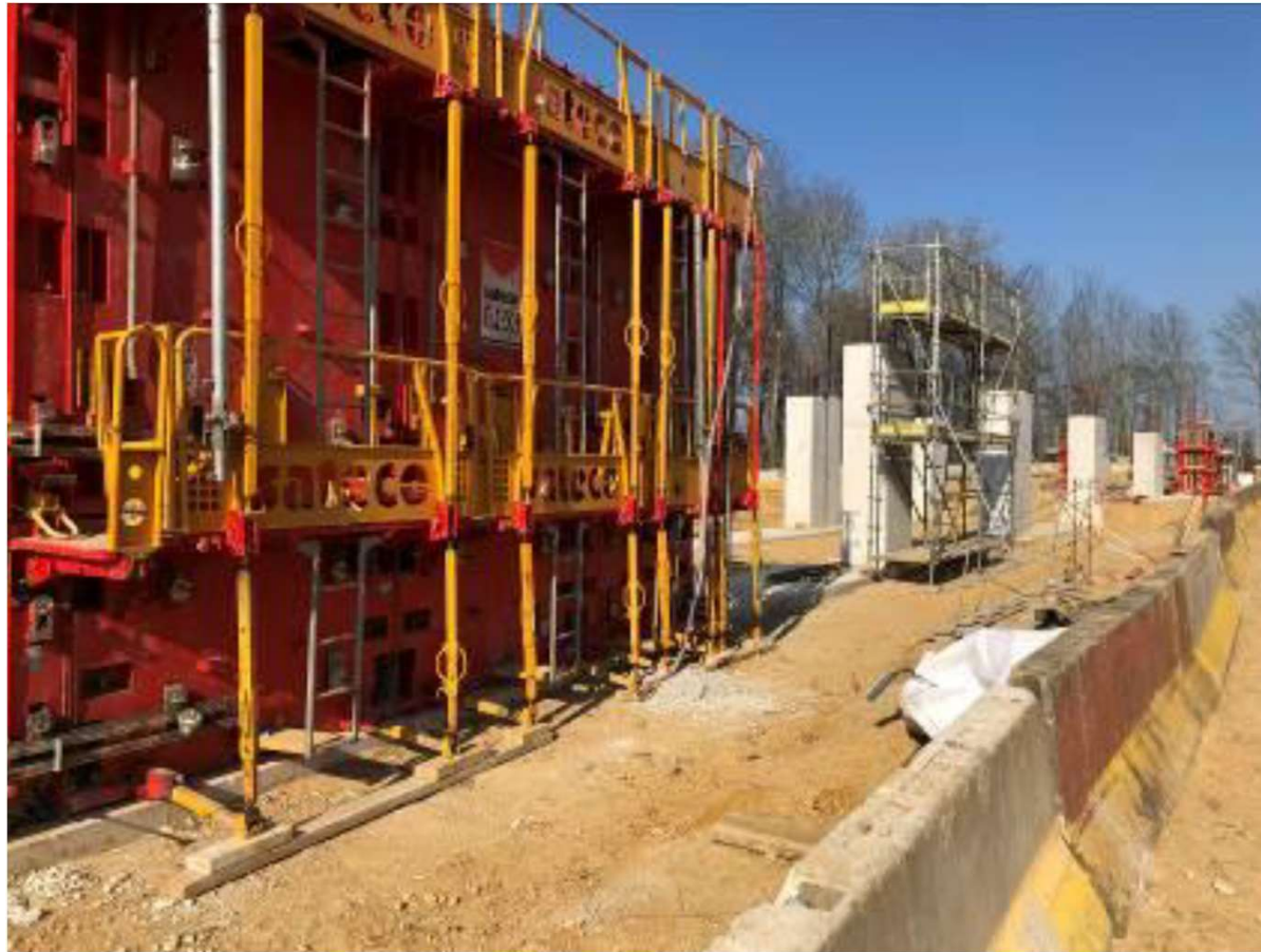
Rampe de transition en cours de réalisation
