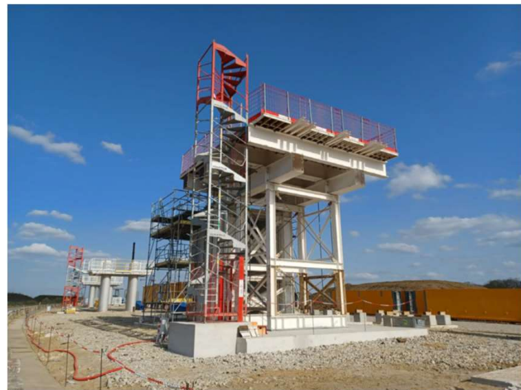
Montage de la poutre de lancement
