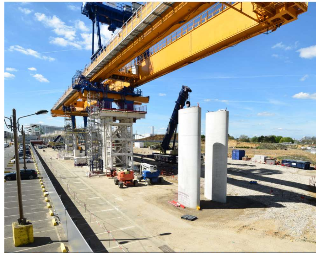
Poursuite de l'assemblage sur piles
