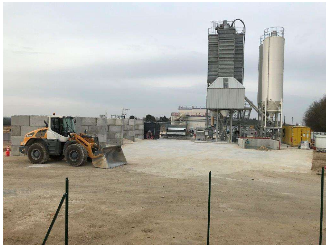
Centrale à béton - (béton bas carbone)
