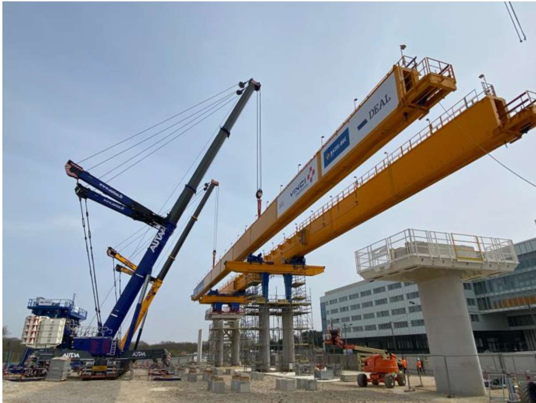
Levage de la poutre de lancement le 28 mars 2022
