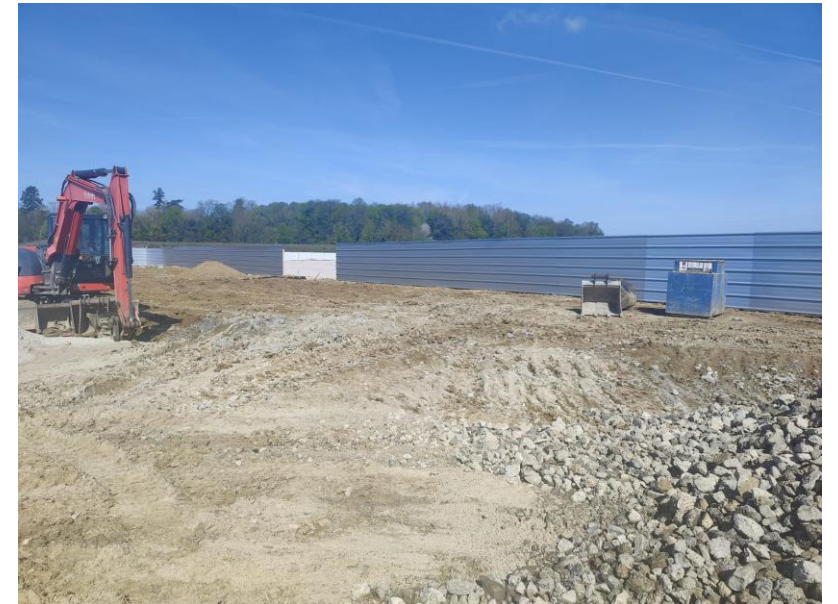
Visite de chantier du 15-04-22
