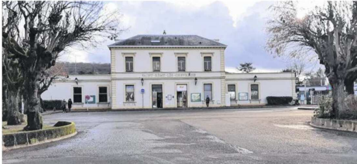
Pour la RATP, la construction de 4 voies de garage est indispensable pour améliorer la qualité du RER B.
