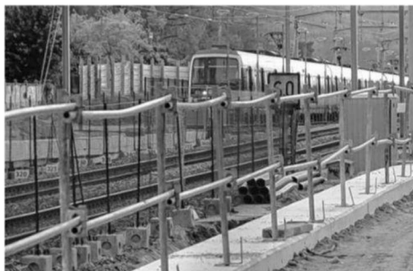
Des travaux de maintenance ont commencé à la gare.
